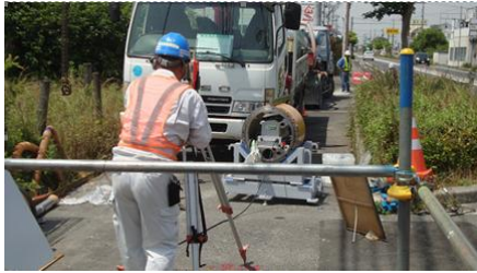
Sリードを使用する際の施工現場での準備作業
