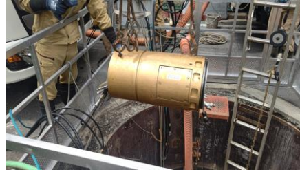
Sリードを搭載した先導管の投入
