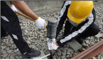
打設杭打ち込み
